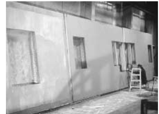
(d) De eerste stuclaag wordt in de fabriek aangebracht.
