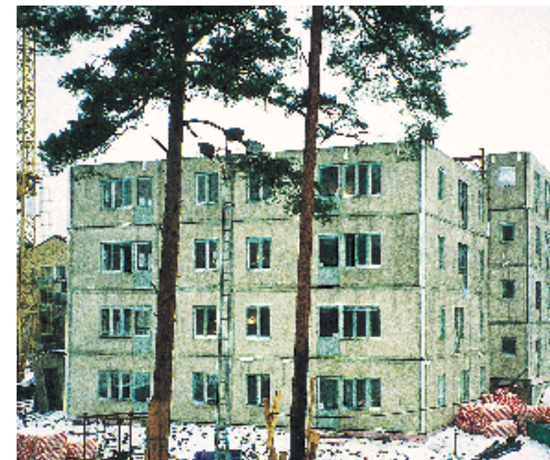
Beeld van de ruwbouw. Zichtbaar zijn de gevelelementen met de eerste, fabrieksmatig aangebrachte stuclaag.
