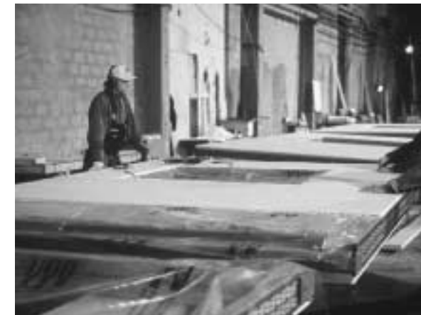
(c) Na het omkeren van een gevelelement wordt de folie en de gipskartonplaten aan de buitenzijde aangebracht.
