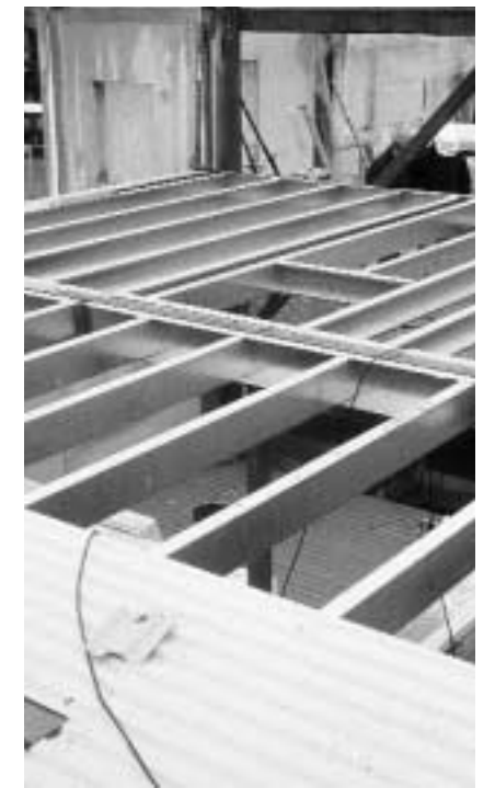
(f) Montage van de vloerelementen met aan de bovenzijde een dunne geprofileerde staalplaat; in het midden is de bovenzijde van een hoedlijger zichtbaar.
