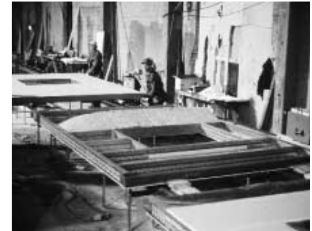
(b) Aanbrengen van isolatie en de gipskartonplaten aan de binnenzijde.
