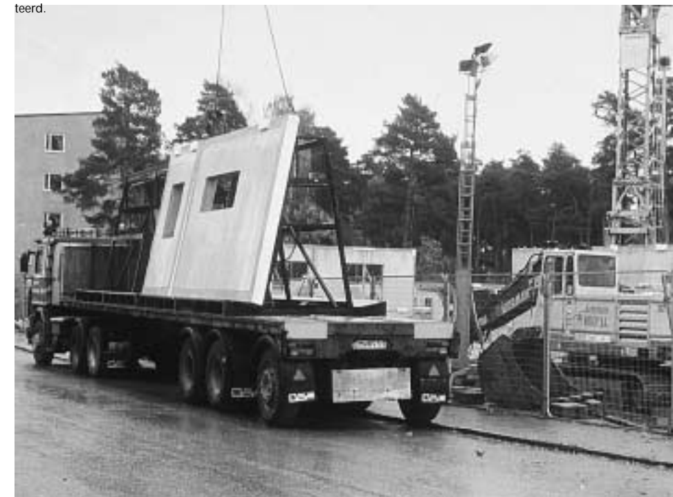
(e) De elementen worden op de bouwplaats direct van de vrachtwagen gemontereerd.
