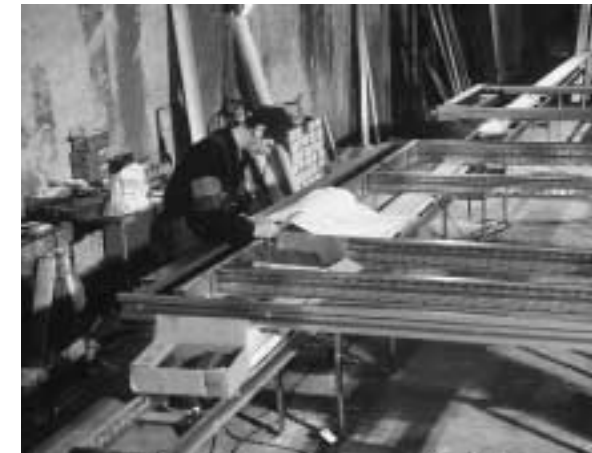
(a) Assemblage van een gevelelement.
